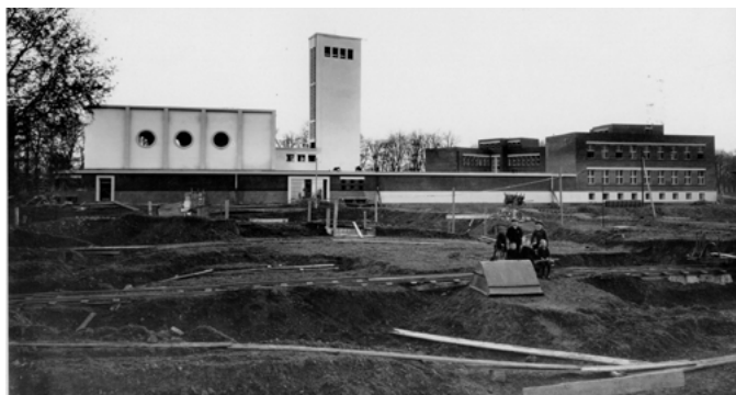
(O35) Sbor před dostavbou a osazením oken
