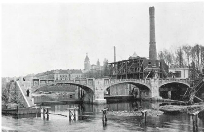
(O73) Stavba nové vodní elektrárny, fotografie o z roku 1909
