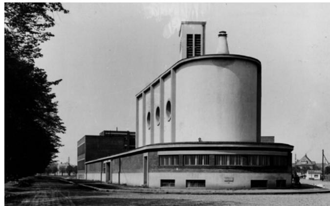
(O37) Sbor po dostavbě v roce 1929
