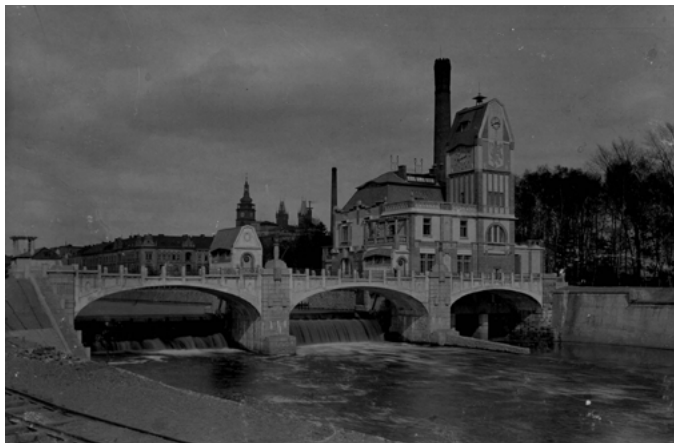
(O70) Vodní elektrárna Hučák, fotografie stavby po roce 1912
