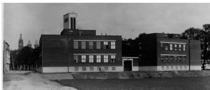
(O36) Sbor po dostavbě v roce 1929
