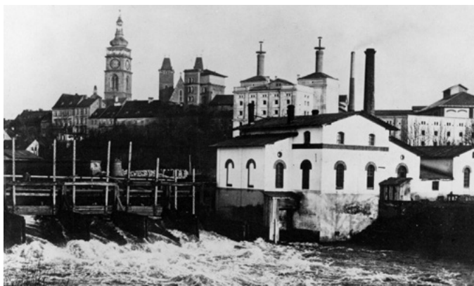
(O72) Původní elektrárna a most, fotografie stavby před rokem 1901
